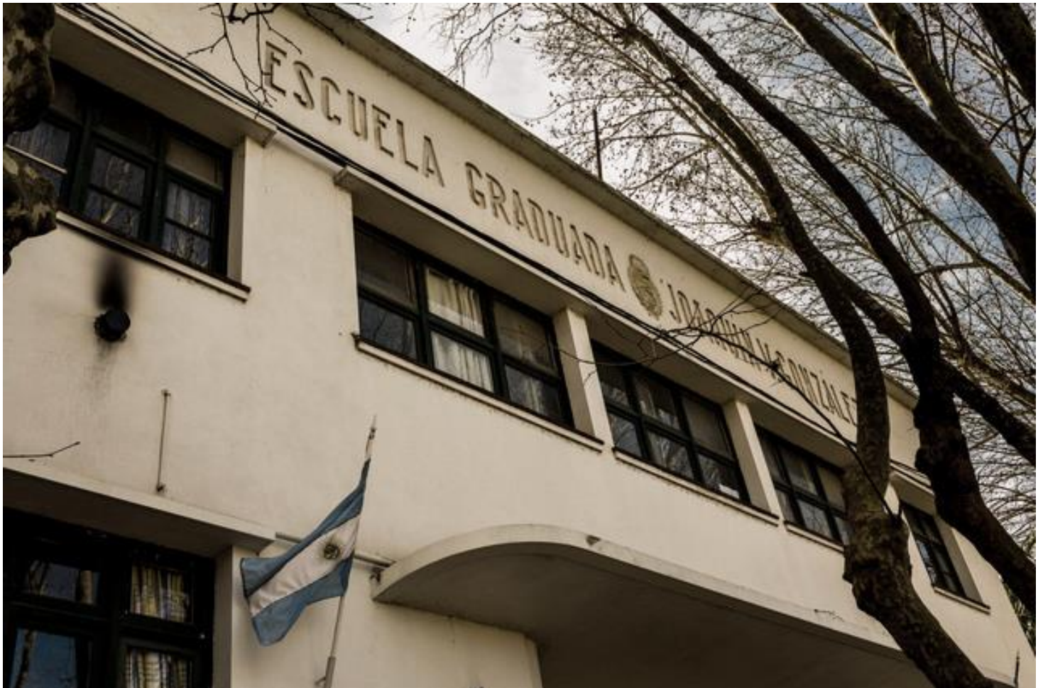
EXTERIOR- FRENTE SOBRE CALLE 50.
